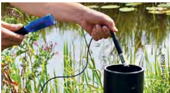
Photo 3 : Installation d'un capteur de pression
