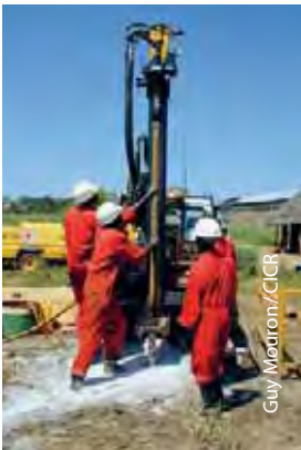
Photo 1 : Réalisation d'un forage
