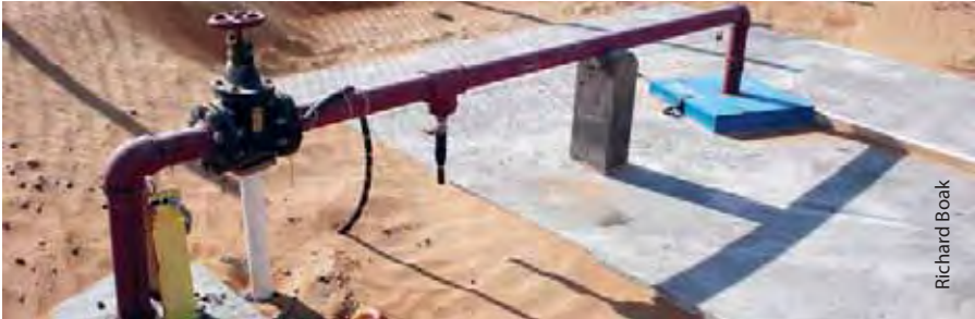
Photo 11 : Robinet à opercule sur la conduite de refoulement
