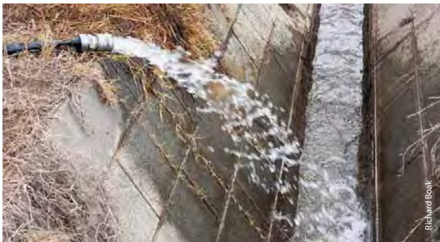
Photo 12 : Évacuation dans les eaux de surface
