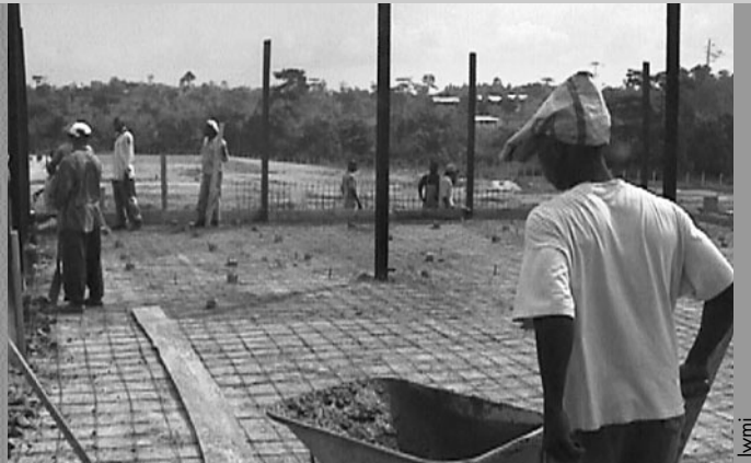
Station de compostage en construction
