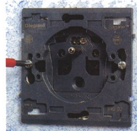
9. Fixation de la prise par montage à vis. Les vis de serrage sont positionnées à l'extérieur du mécanisme.
