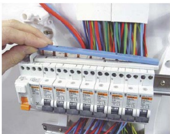
12 - Placez la barre de pontage de neutre et vissez.
