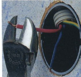
2. Couper les extrémités des âmes conductrices.
