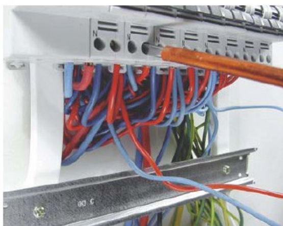
15 - Raccordez les lignes sous les protections.
