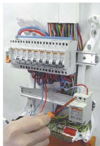
16 - Raccordez les autres dispositifs devant équiper le tableau électrique (transformateur, contacteur jour/nuit...).
