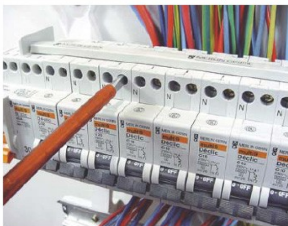
11 - Vissez fermement les vis des phases.
